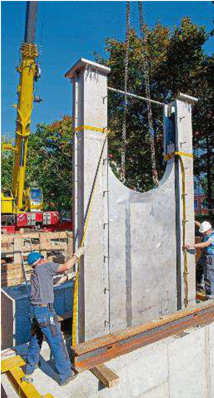
Automatische Wehre machen Kanäle selbst zum Speicher, hier an der Storkower Straße in Prenzlauer Berg.
