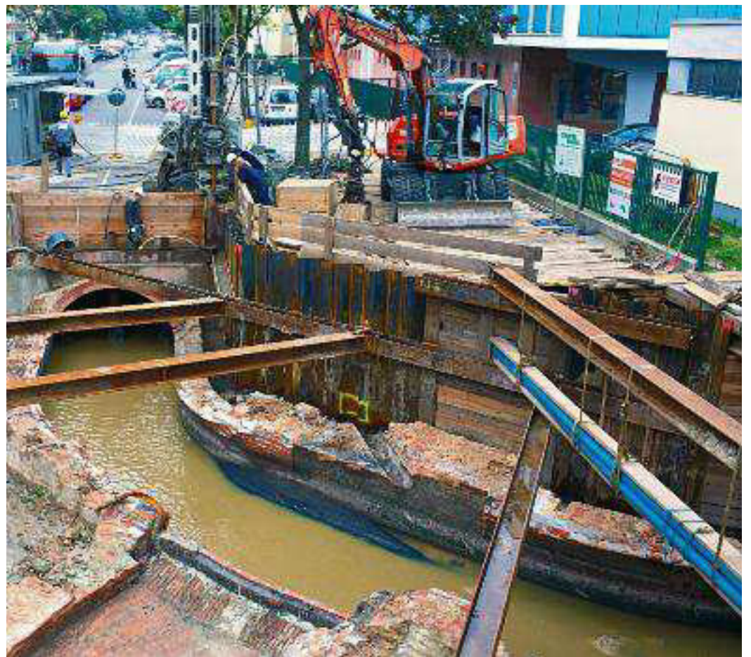
Operation am offenen Herzen: Großer Mischwasserkanal an der Bellermannstraße in Wedding mit Überlaufkanal zur Panke. Die Schwelle wird angehoben und neue Dreckrechen werden installiert.
